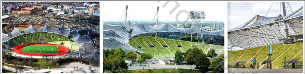
Рис.1. Біоміметичний дизайн полегшеної конструкції кабельної сітки Мюнхенського Олімпійського стадіону. Режим доступу: https://pixabay.com/ru/photos/-565522/
